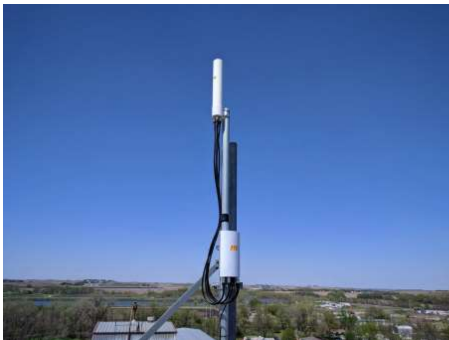
شکل ۱۷ تصویر از دکل و آنتن شبکه نقطه به چند نقطه با ساختار ستاره برند میموسا
